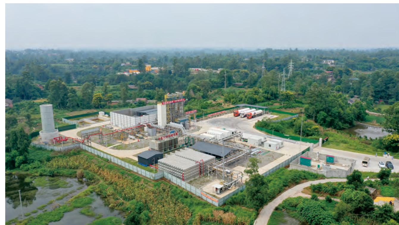
▲ 金石103井LNG橇装项目
